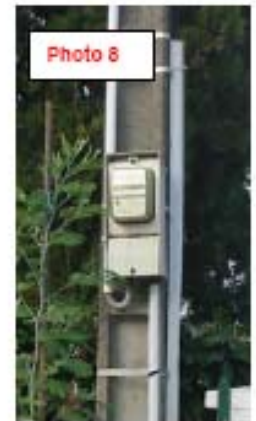
Compteur extérieur apparent
