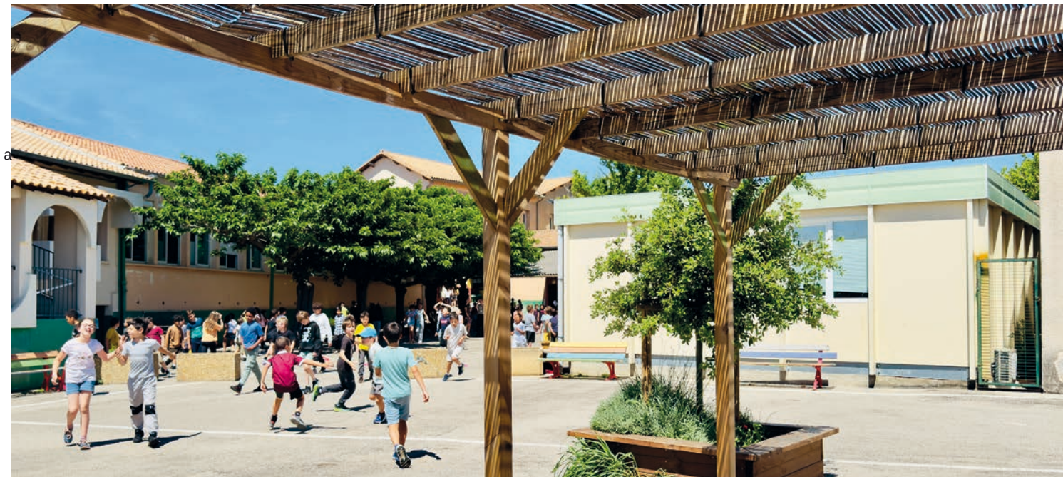
En complément des plantations d'arbres, des pergolas ont été installées. Elles permettent aux élèves de s'abriter du soleil mais aussi de baisser la température des modules attenants.
