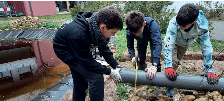
Installation de l'exutoire de la mare vers le réseau pluvial
